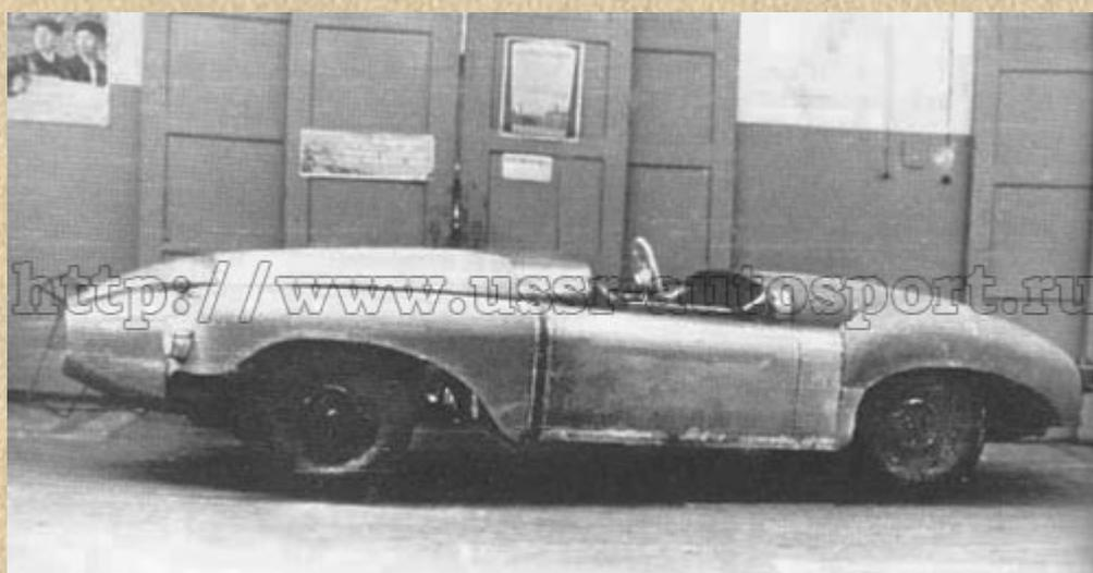
ЗИС-112/2 в процессе постройки (кузов еще не покрашен, ветровое стекло не установлено).
